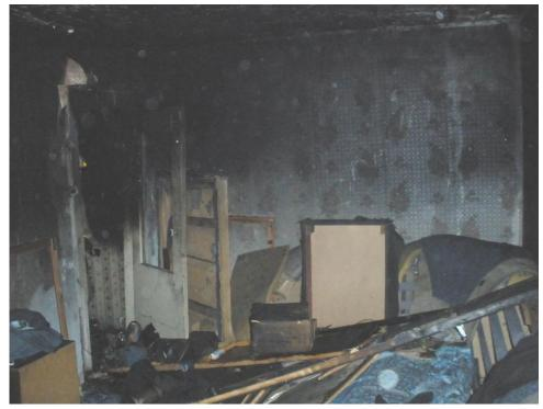
конструктивных элементов стены в межкомнатных перегородках и переход пламени в
